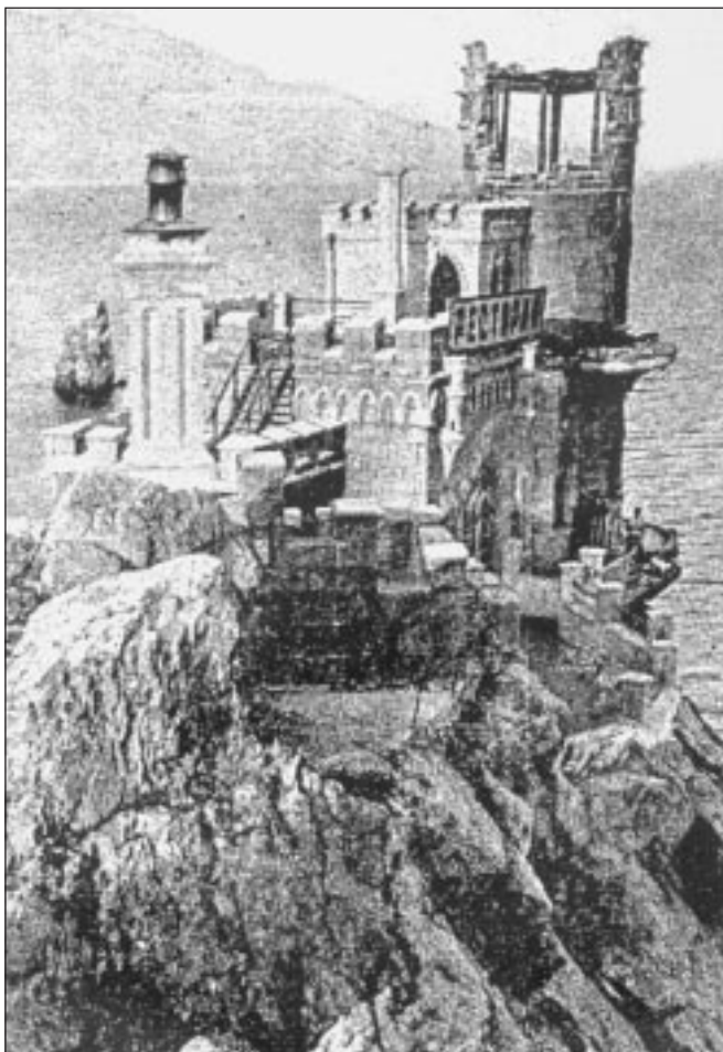
Знаменитое «Ласточкино гнездо» после сентябрьского землетрясения. Башня разрушена, видны трещины в скале.
