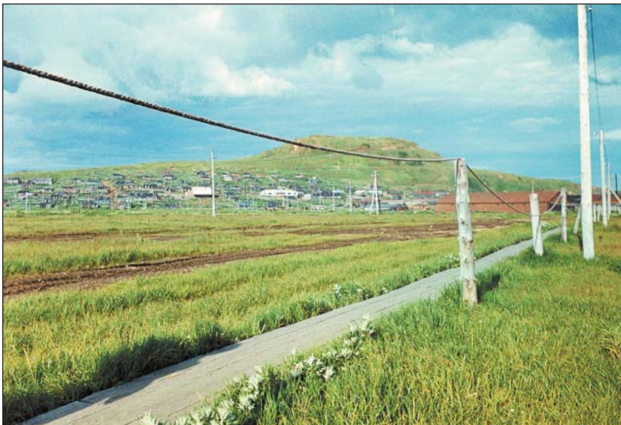
Нижняя терраса, на которой первоначально располагался Северо-Курильск. На заднем плане — новый город, построенный на высокой террасе. Канаты, расположенные вдоль дороги, служат поручнями зимой, когда в пургу наметает сугробы до 2—3 м.
