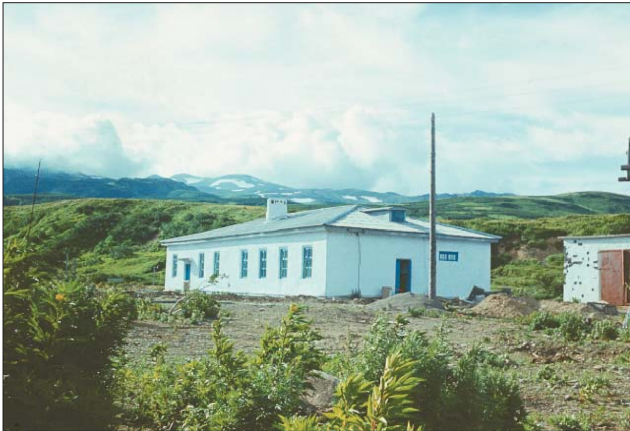
Сейсмостанция в новом Северо-Курильске, построенная после 1952 г.
